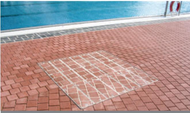
Tapa de pozo instalado en una piscina
