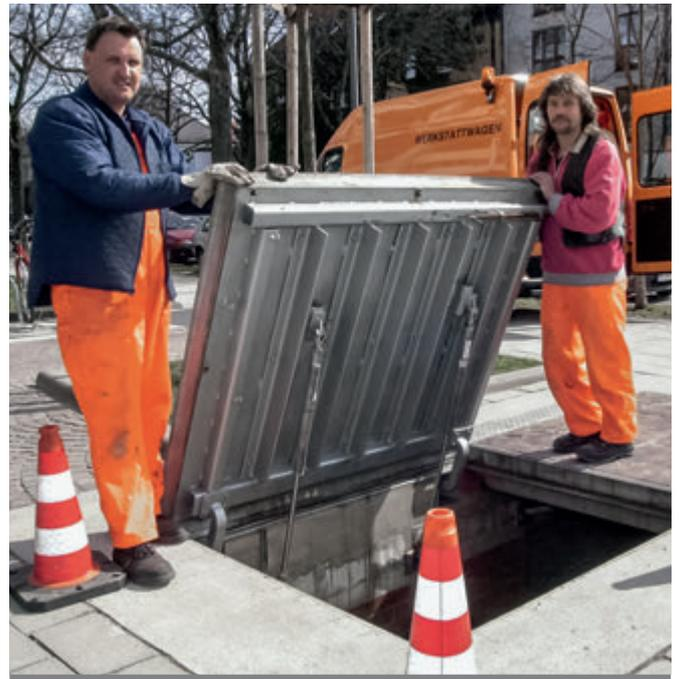
Tapa de pozo con amortiguador a gas
