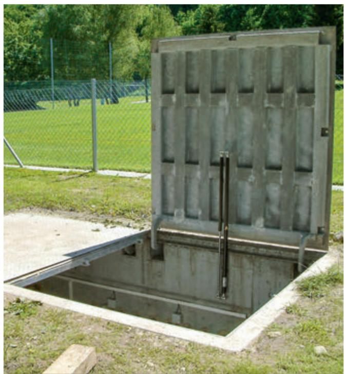
Tapa de pozo con amortiguador a gas
